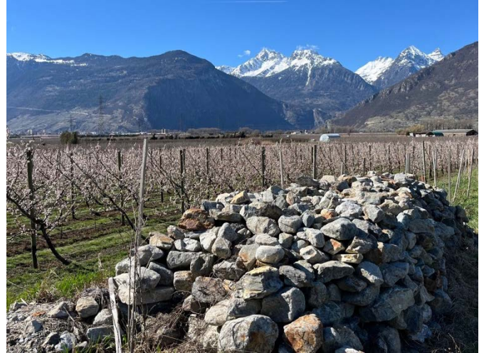
Fig. 4 Pierrier construit à partir de matériel local d'excavation. Charrat, 7 mars 2024. © E. Revaz
